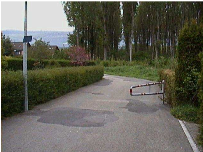
Photo 1: Barrière vue depuis la rue du Coin-de-Terre
