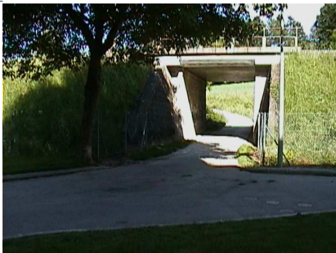
Photo 1: Vers Cheseaux-Noréaz, à la hauteur de la bifurcation Champ-Pittet
