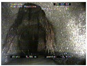
Au vu de ce constat, le collecteur TC  $\emptyset$  40 cm a du être remplacé dans la foulée sur environ 75m par un tuyau PVC  $\emptyset$ 400 mm totalement enrobé avec du béton.
