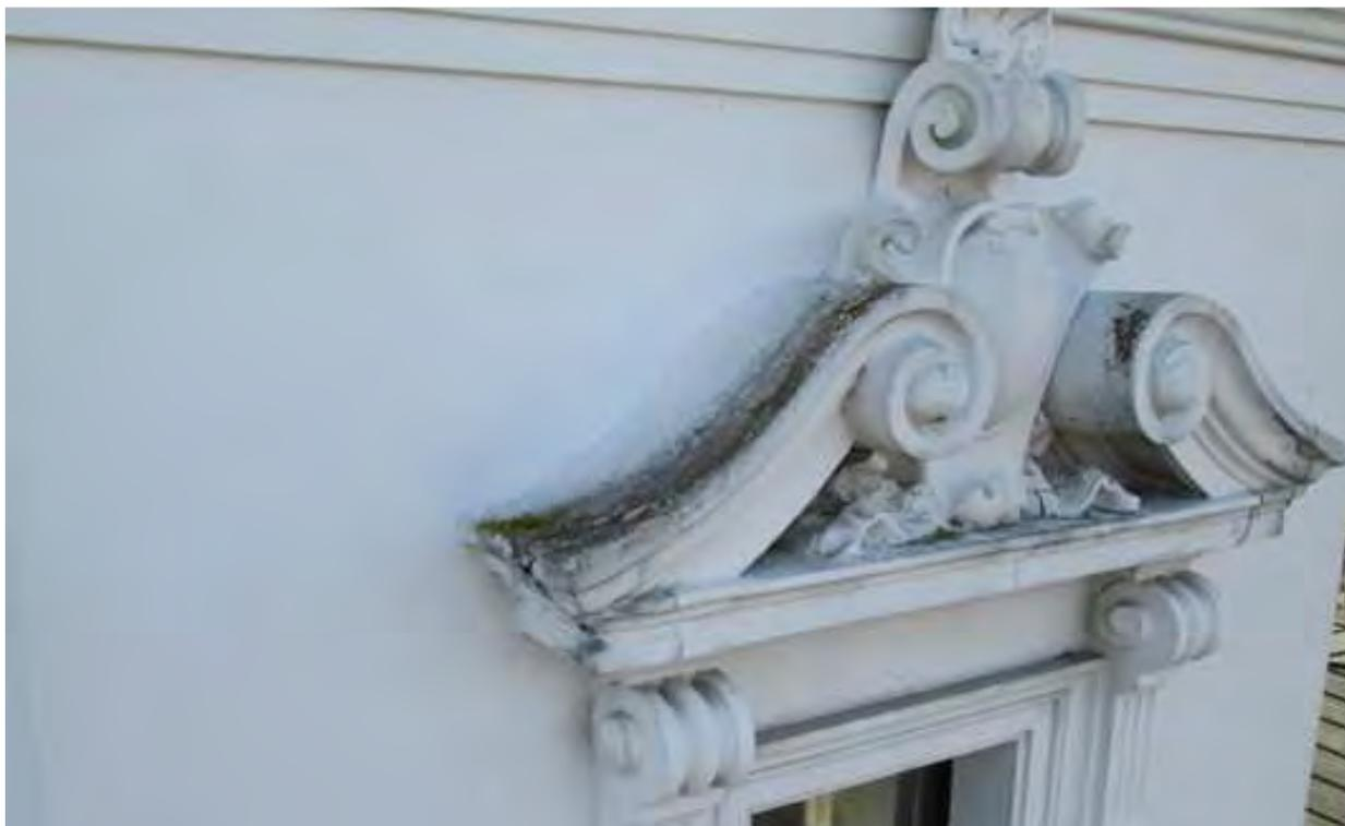
Modénatures et façade avant sablage, photo prise lors du contrôle préalable avec la nacelle. Très peu de fissures visibles et dégâts légers, élément visuellement réparable sans problème à l'aide d'injections de résine à deux composants ainsi que rhabillages de surface en mortier minéral. Aucune armature métallique n'est visible, et aucune trace de rouille permettant d'en déceler leur éventuelle présence et leur carbonatation.
