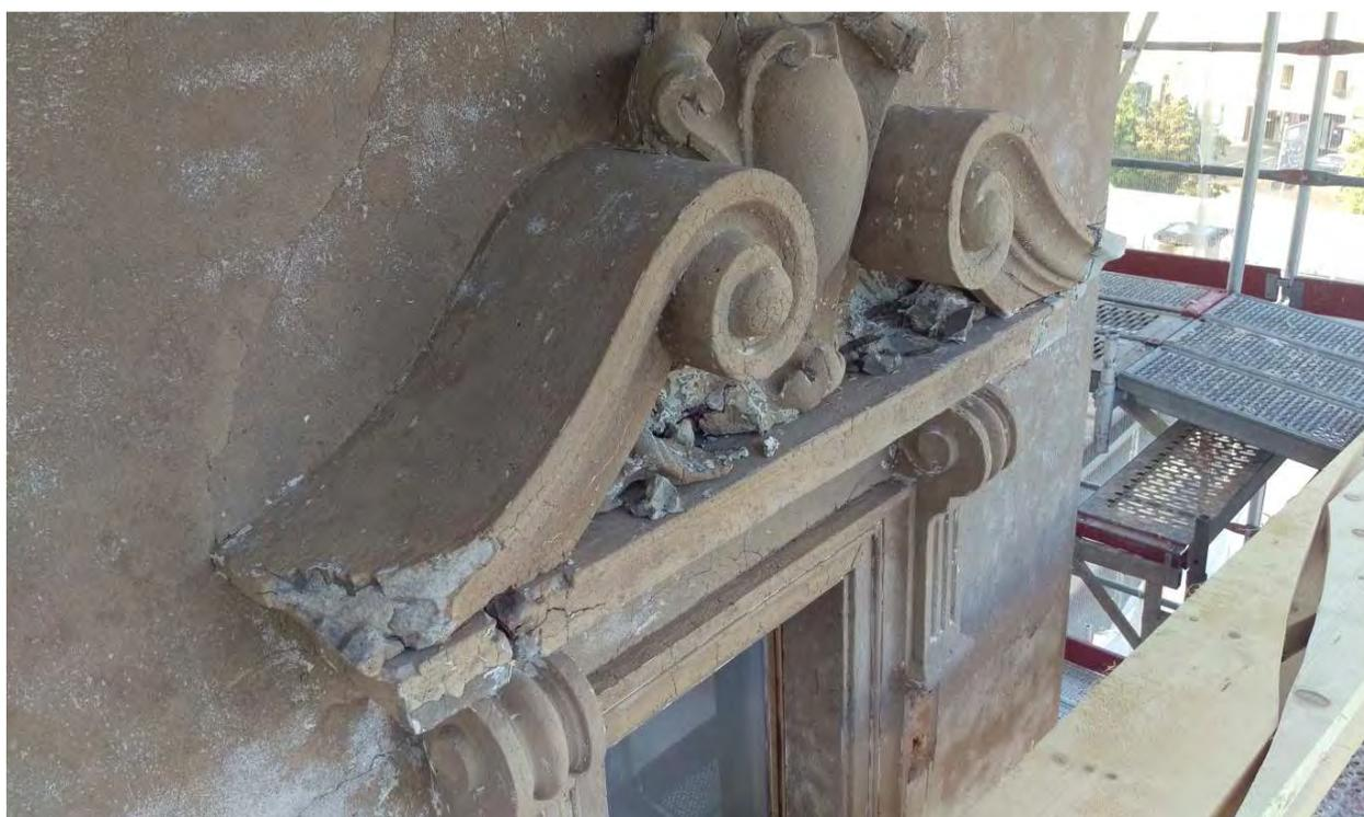
Le même élément après sablage et séchage des matériaux qui se sont désagrégés, nombreuses fissures visibles cette fois. Élément irrécupérable, plus onéreux à rhabiller qu'à refaire à neuf. A remplacer selon les maçons, le département des Monuments Historiques et la direction des travaux.
