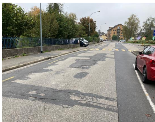
Figure 1 - Exemples de dégradations à la Rue du Curtil-Maillet et au carrefour Rue d'Orbe/Rue du Cheminet
