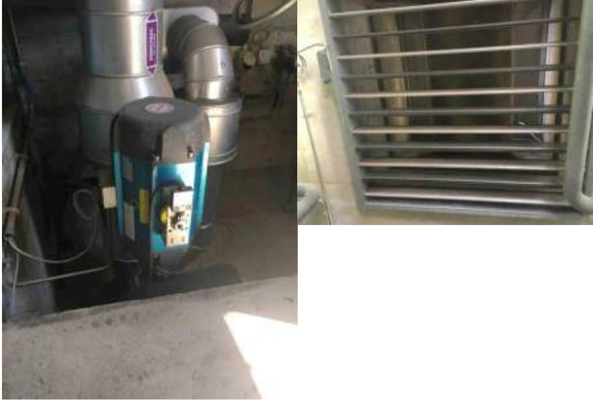
Figure 5-2 : Vue sur une électrovanne de sécurité (à gauche) et la ventilation en toiture
