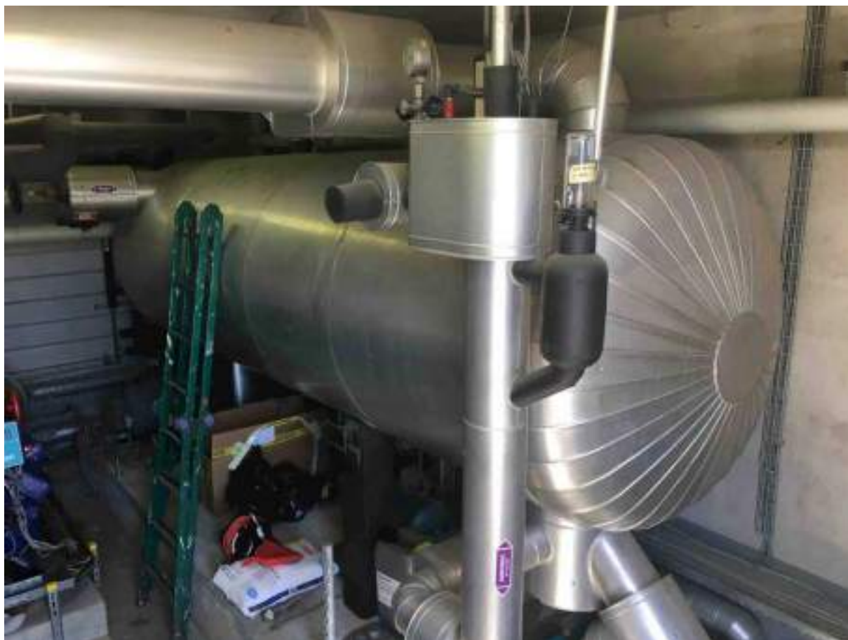
Figure 3-6 : Vue sur le réservoir d'ammoniac
