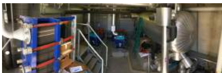
Ecoscan, OPAM patinoire, vue sur le local technique des installations de froid de la patinoire. Le local comprend un réservoir d'ammoniac d'une capacité de 4'700 litres
