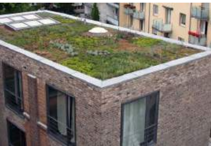
Végétaliser les toitures
