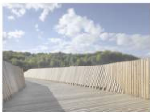
Passerelle de la Sallaz, Lausanne, 2b architectes
