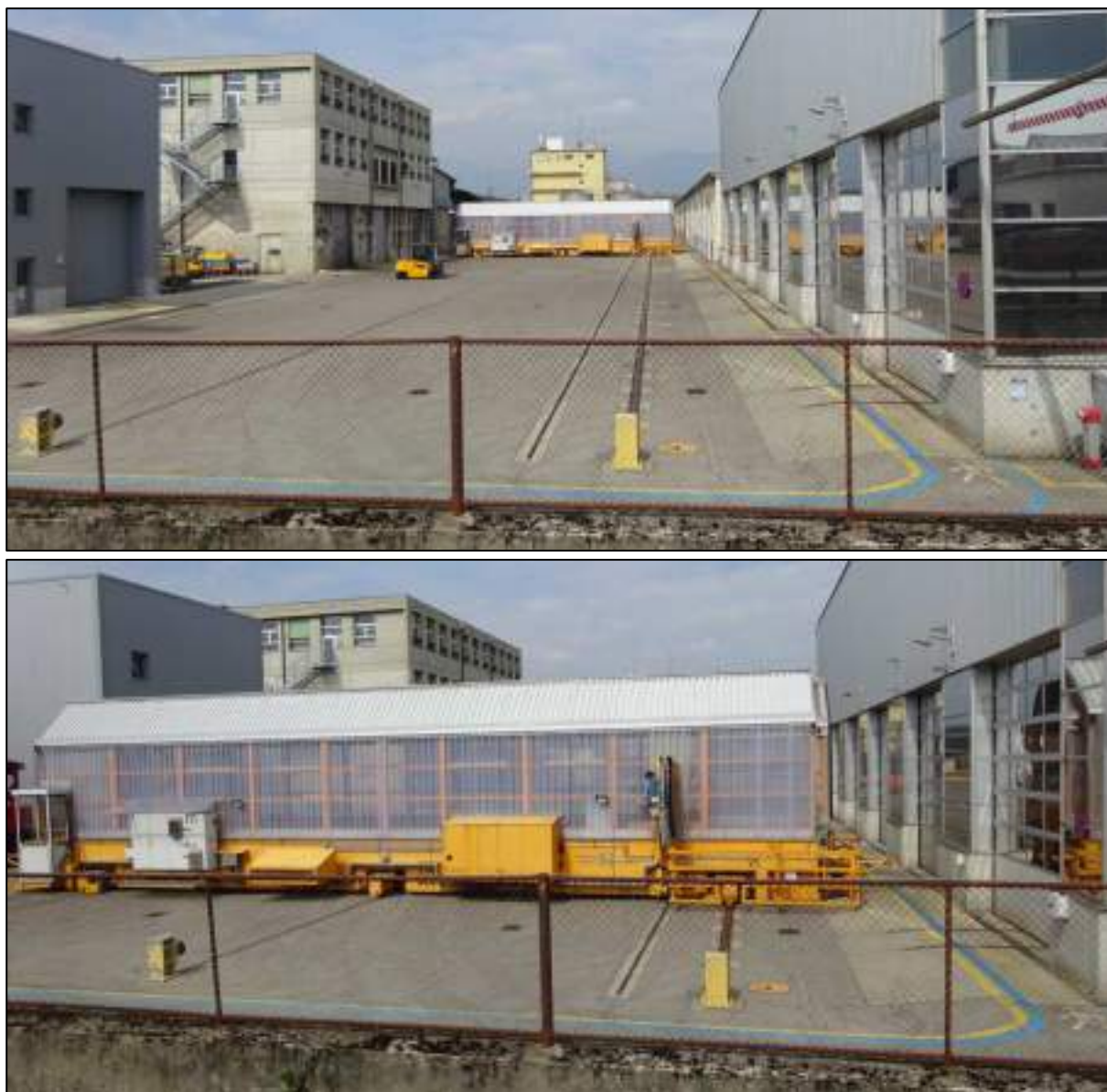
Figure 5.22 Photographie de la situation des ateliers CFF
