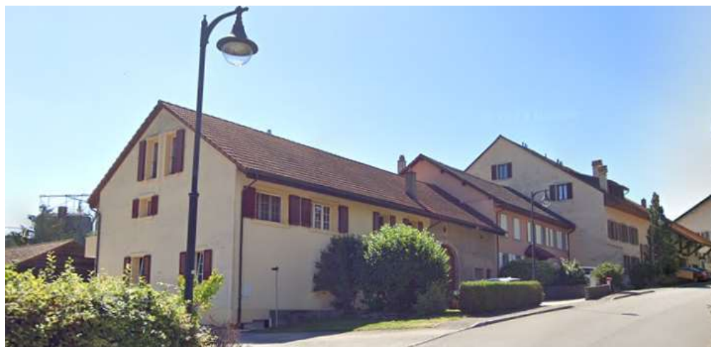
Gressy, entrée Est
