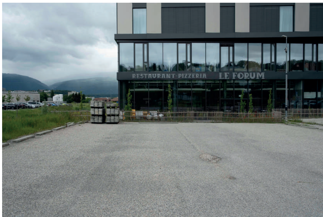
Figure 44 : Vue sur l'espace de la future place publique
