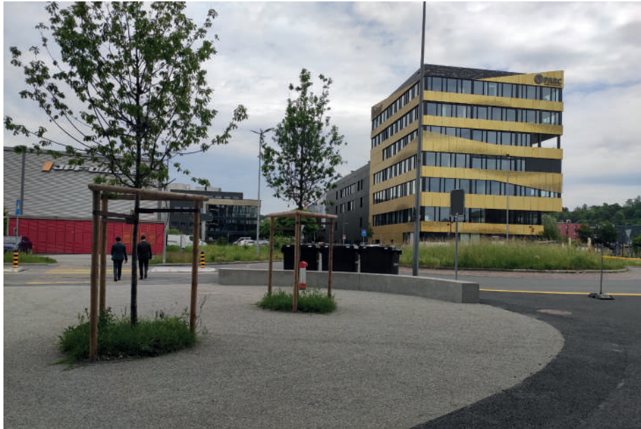
Figure 35 : Vue sur le franchissement piéton de la route de contournement
