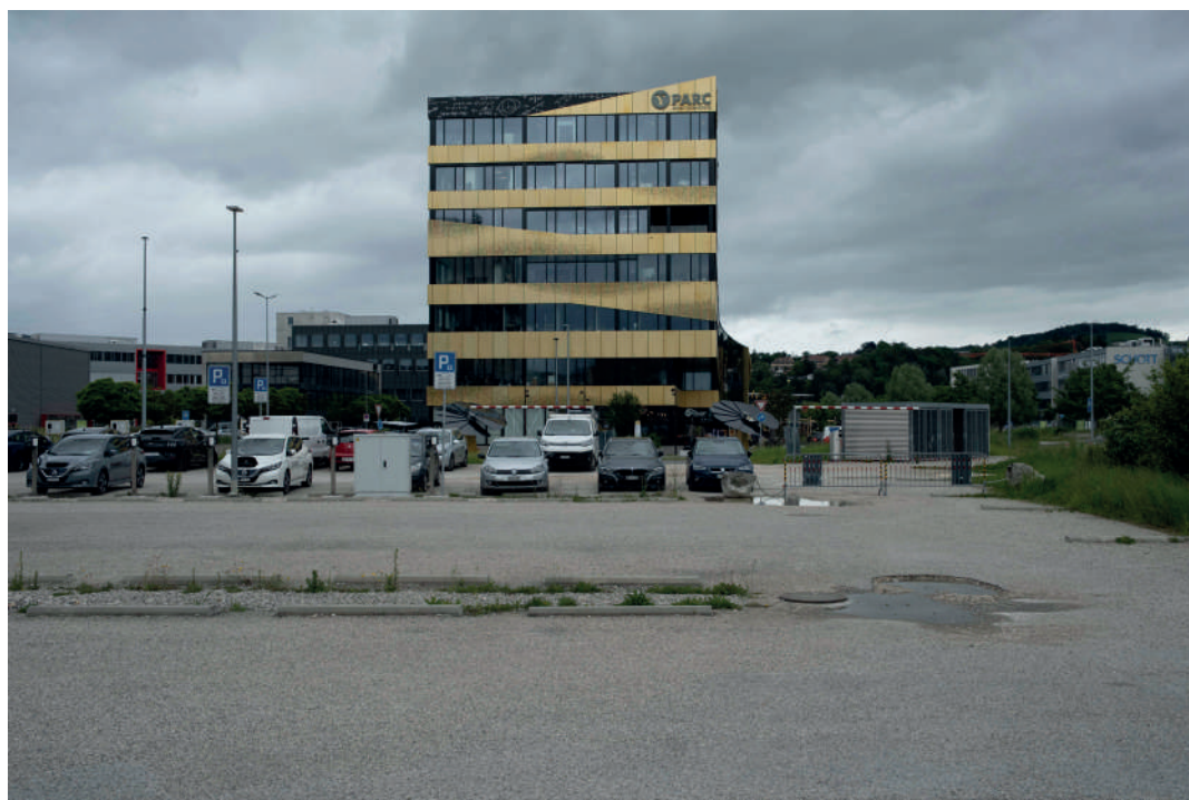
Figure 43 : Vue sur l'espace de la future place publique
