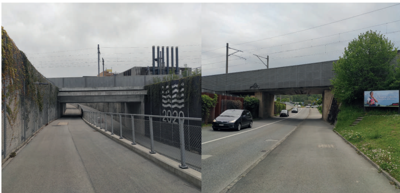
Figure 21 : Vue sur les deux voies de passage entre le quartier Pierre de Savoie et le Parc
