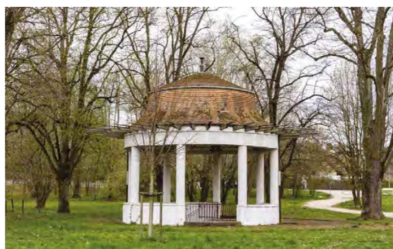
source : rotonde, Yverdon-les-Bains @YLB @Thierry Porchet
