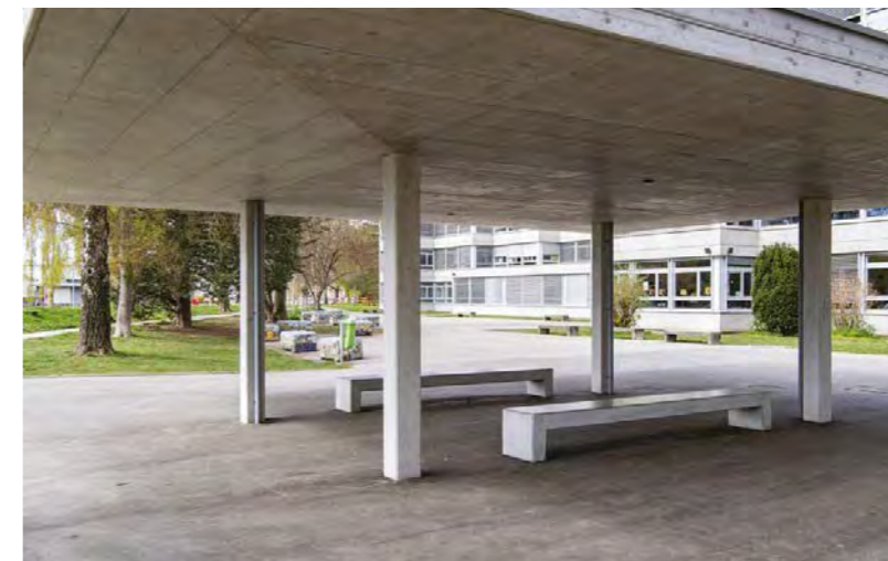
source : couvert, Yverdon-les-Bains @YLB @Thierry Porchet
