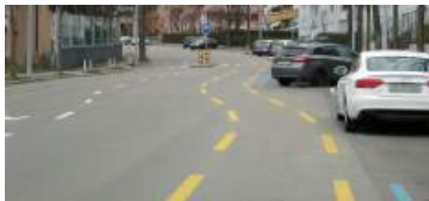
Lausanne, largeur libre de 50 cm entre le stationnement et la bande cyclable © Ville de Lausanne
