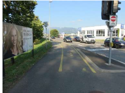
Carrefour Rte de Ste-Croix / Av. de Grandson En venant de Chamard, le cycliste est orienté sur la piste cyclable et n'a ensuite plus la possibilité de tourner en direction de Grandson.
