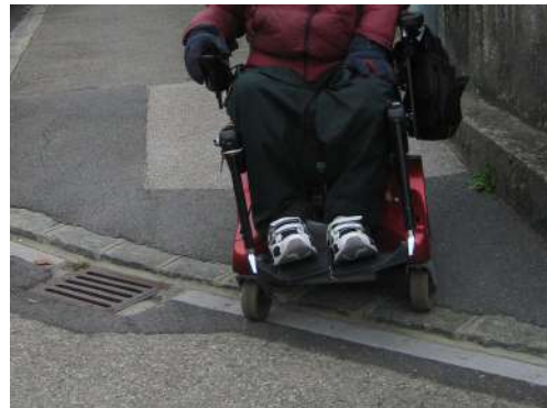
Rue Roger-de-Guimps Possibilité de franchir les trottoirs et qualité du revêtement : éléments-clés de l'accessibilité des PMR
